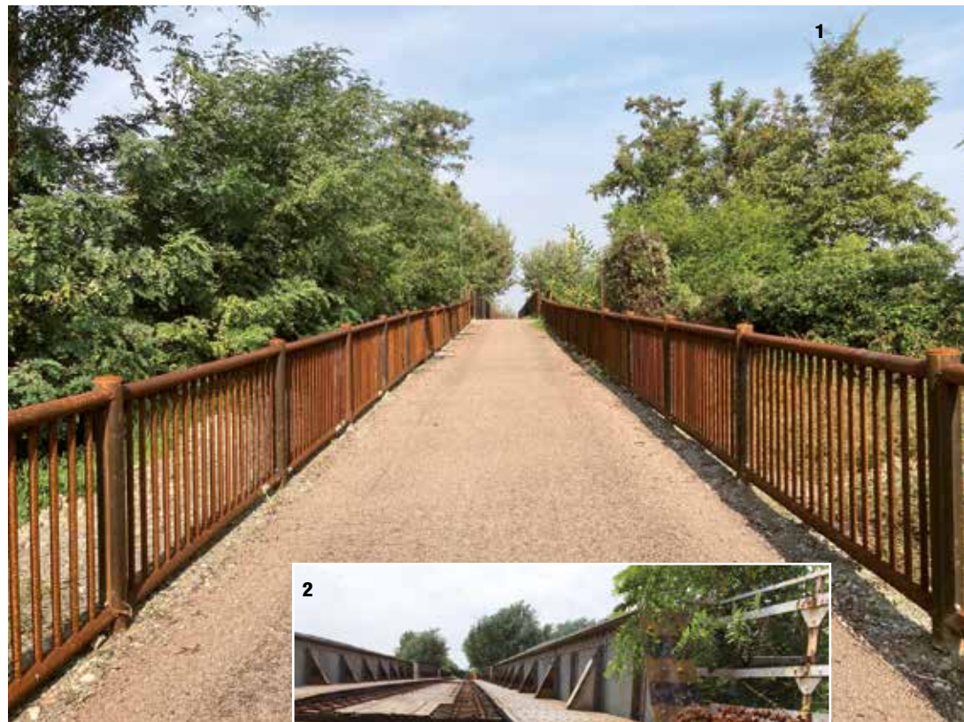
1. Parapetti Cortensafe su rilevato delle rampe
