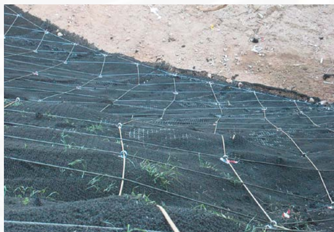
Messa in sicurezza di versante stradale in materiale sciolto, mediante posa in opera di KMat RF Metal ® con il duplice scopo di contenere superficialmente il materiale di riporto e controllare l'azione di possibili agenti erosivi
