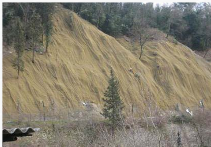
Rivestimento parete rocciosa disgregata con KMat RF Metal ® di colore marrone per aumentare l'effetto mascherante e ridurre l'impatto visivo dell'intervento
