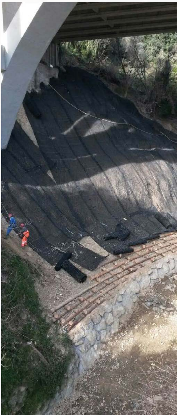
Rivestimento parete rocciosa disgregata con KMat RF Metal ® di colore marrone per aumentare l'effetto mascherante e ridurre l'impatto visivo dell'intervento
